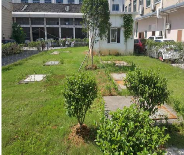
废水处理系统
