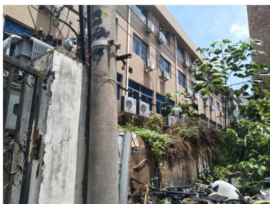
图 2.6-7 项目北侧照片
