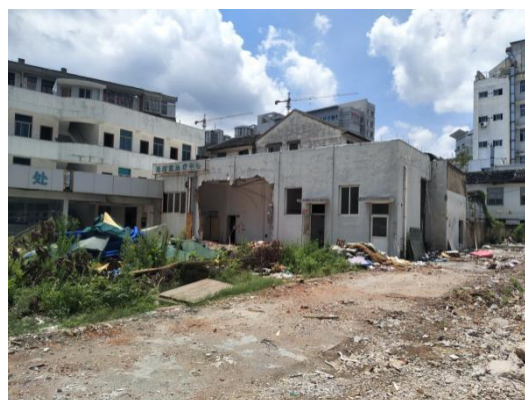
3.2-2 改造装修建筑现状
