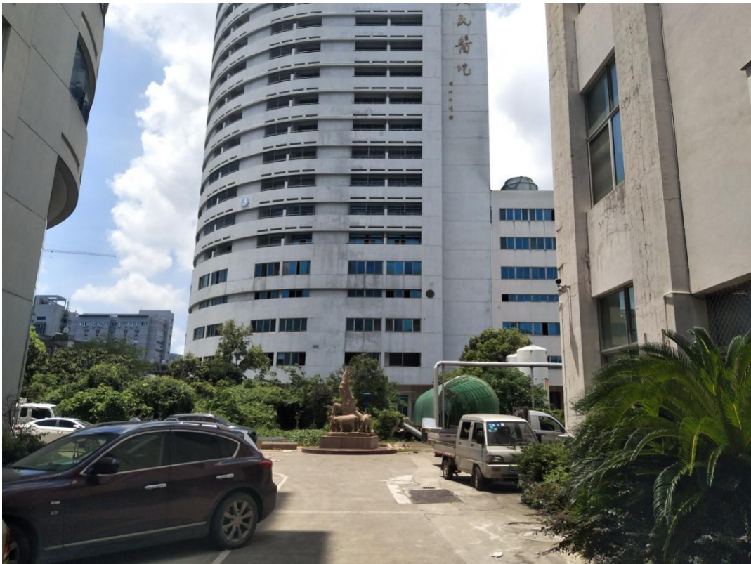
图 2.6-3 项目东侧温岭市第一人民医院公寓楼
