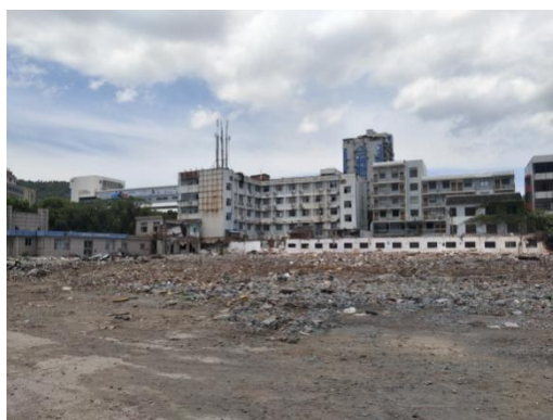
图 3.2-1 拆除重建地块现状
